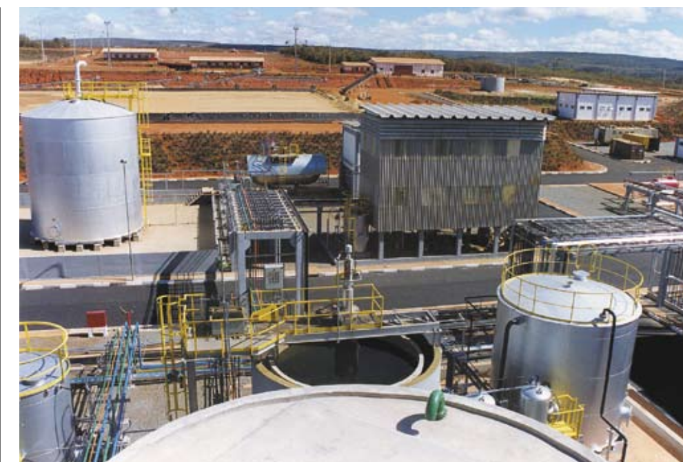
Área de tratamento químico, parte final do processo de produção do concentrado de urânio
